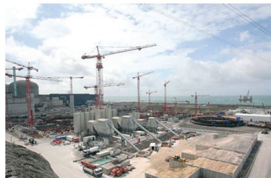
EPR-bygget i Flamanville. Foto: EDF
