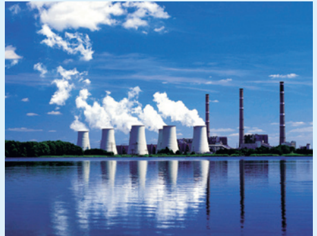
KRAFTVERKET JÄNGCHVALE, TISGLAND. FOTO: VATTENBIL
