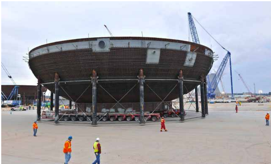
Botten av reaktorinneslutningen för Vogtle – 3. Foto: Southern Co.
