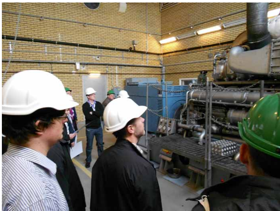
Anställda på Vattenfall under en rundvandring på Barsebäck där bland annat nöddieselgeneratorerna visades. Foto: Annika Leonard
