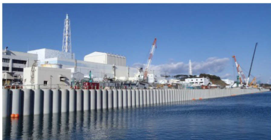
Foto av den isolerande väggen vid strandlinjen och hamnen. Foto: Tepco.
