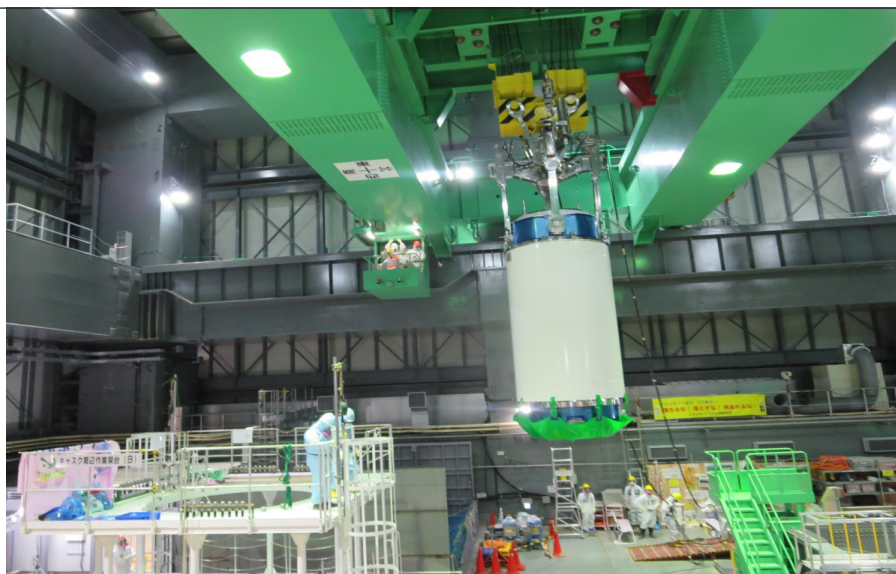
Arbete med att flytta bränsle från bränslebassängen i reaktor 4. Foto: Tepco.
